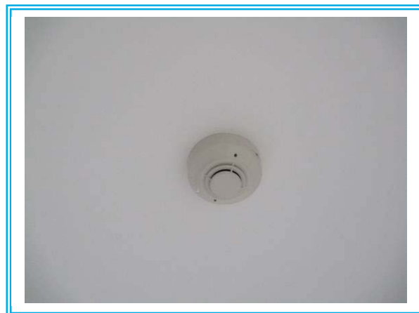
รูปที่ 3-52 การติดตั้งเครื่องตรวจจับควันและเครื่องตรวจจับความร้อน (Smoke Detector, Heat Detector)
