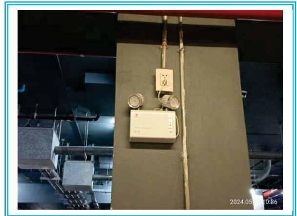
รูปที่ 3-55 การติดตั้งไฟฉุกเฉิน (Emergency Light)
