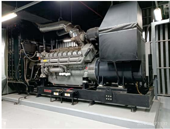
รูปที่ 3-10 ห้อง generator มีการวัสดุกันเสียงไม่ให้มีเสียงดังรบกวนออกไปภายนอก
