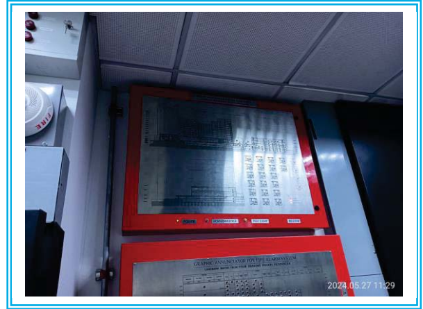
รูปที่ 3-49 แผงควบคุมระบบสัญญาณแจ้งเหตุเพลิงไหม้ (Fire Alarm Control Panel : FCP)
