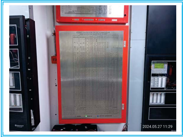
รูปที่ 3-49 แผงควบคุมระบบสัญญาณแจ้งเหตุเพลิงไหม้ (Fire Alarm Control Panel : FCP)
